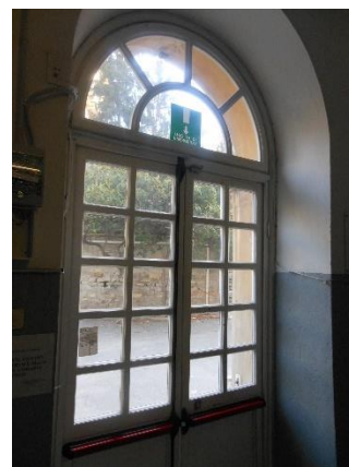
Figura 4.3 - Particolare dei serramenti legno vetro singolo
