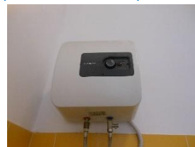
Figura 4.11 - Particolare di un boiler elettrico per la produzione di acqua calda sanitaria
