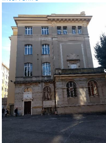
Figura 8.1 – Particolare della facciata su cui intervenire
