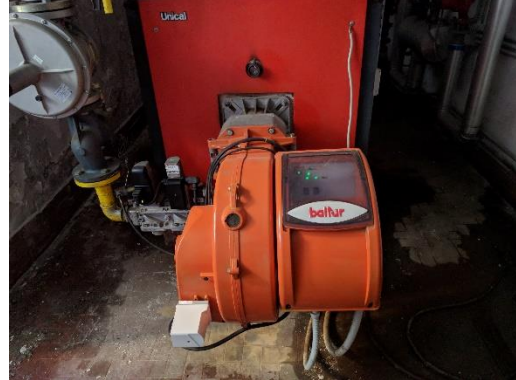
Figura 4.10 - Particolare del bruciatore
