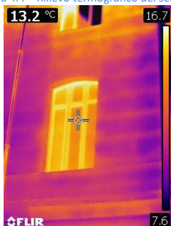
Figura 4.4 – Rilievo termografico dei serramenti
