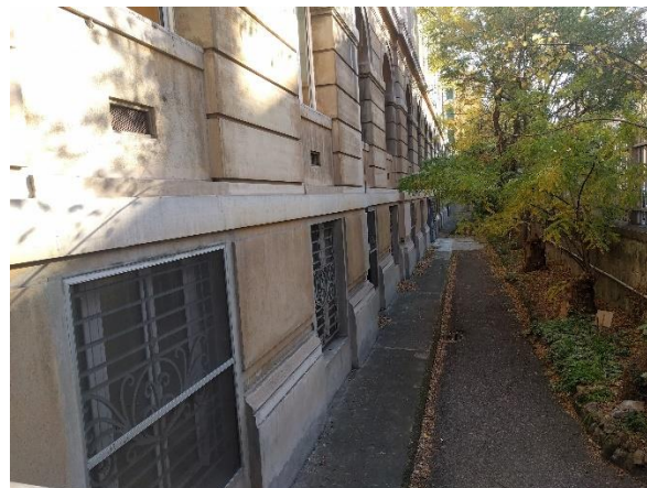
Figura 4.1 - Particolare della porzione di involucro esterna
